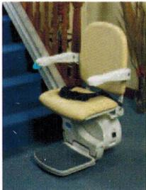
verstaut und kann doch leicht erreicht werden, indem die Armstütze nach oben geklappt wird. Durch Entfernen dieses Schlüssels können Sie den Lift deaktivieren, falls Sie unbefugte Benutzung verhindern möchten.
